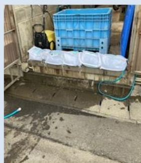
土のう塞ぎ止め訓練
