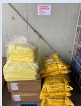
化学物質油緊急時 漏洩用資材の設置 ・吸収マット ・土のう ・おがくず
